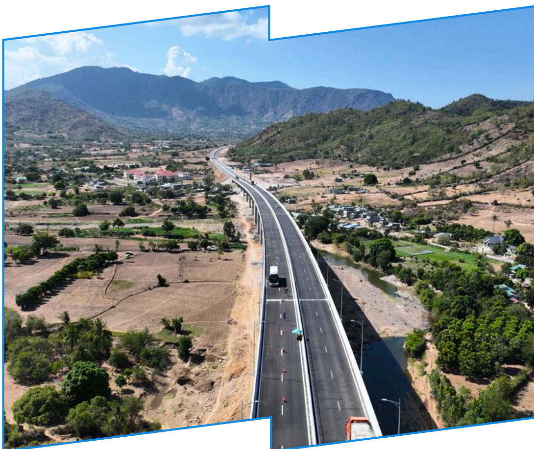
Đường cao tốc Bắc Nam phía Đông (đoạn Nha Trang - Cam Lâm), khánh thành năm 2024
