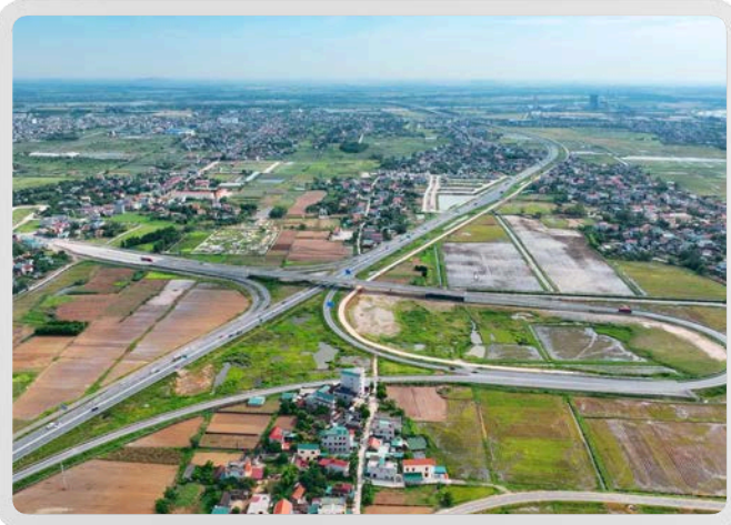
Nút giao trên Đường cao tốc Bắc - Nam (đoạn Cao Bồ - Mai Sơn)
