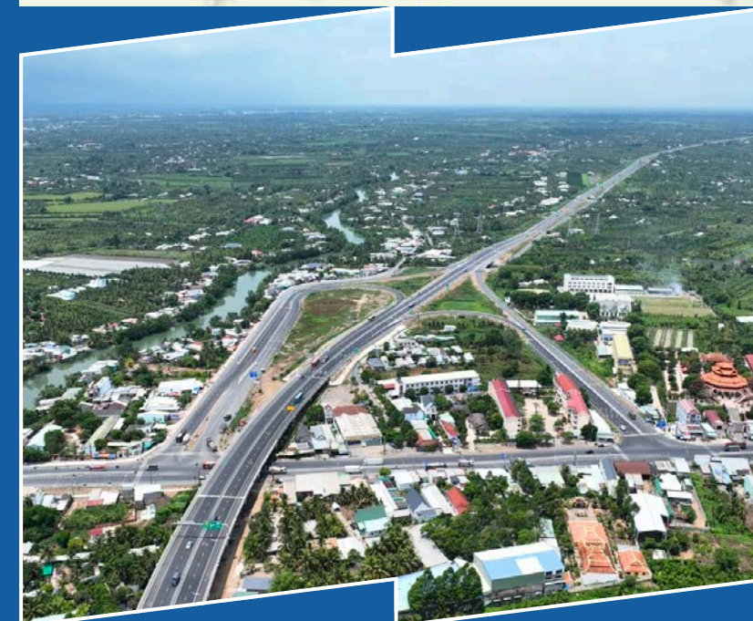
Đường cao tốc Bắc Nam phía Đông (đoạn Mỹ Thuận - Cần Thơ) khánh thành năm 2023
