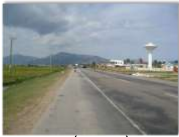
San lấp mặt bằng Khu công nghiệp tại Km1548+400 QL1 gây úng ngập
