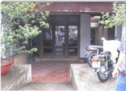
Nhà dân thấp hơn cao độ mép đường tại Km959+700 QL1
