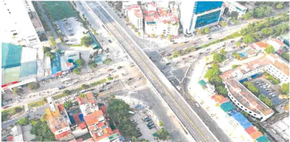
(Hình ảnh dự án cầu vượt nút giao giữa đường Hoàng Quốc Việt – đường Nguyễn Văn Huyền)
