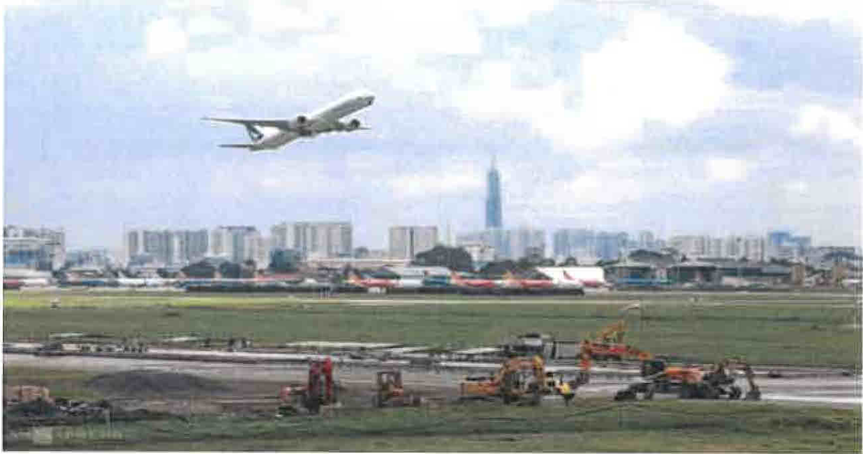
(Hình ảnh dự án cải tạo, nâng cấp đường cất hạ cánh, đường lăn Cảng hàng không quốc tế Tân Sơn Nhất)
