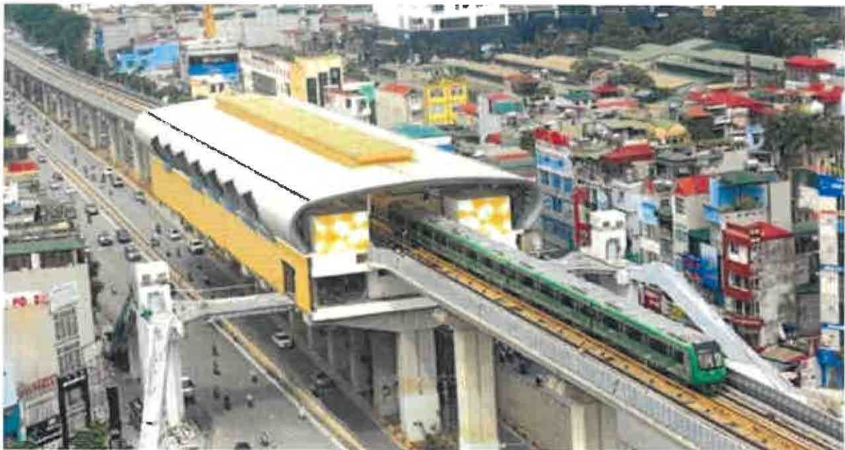
(Hình ảnh dự án đường sắt đô thị Hà Nội, tuyến Cát Linh – Hà Đông)
